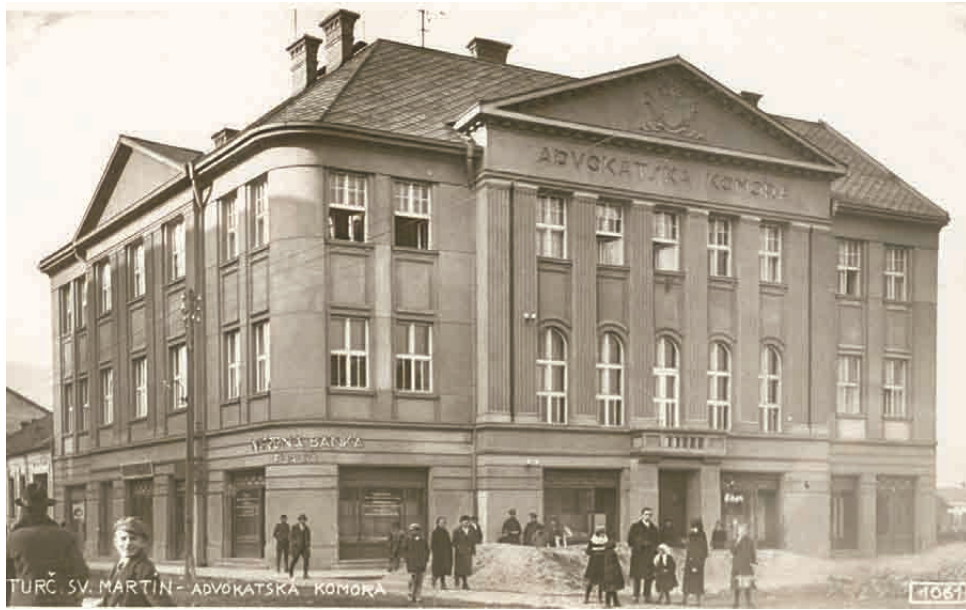
Budova Advokátskej komory v Martine, okolo roku 1930.
