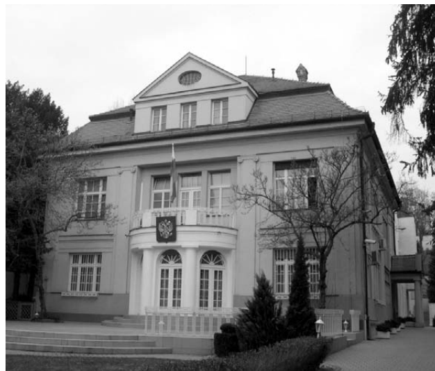
Exteriér vily Pavla Fábryho, súčasný stav
